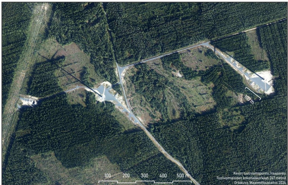
Kuva 5.1 Esimerkki toteutuneesta tuulivoimala-alueesta ja sähkönsiirtorakenteista ilmakuvassa.
