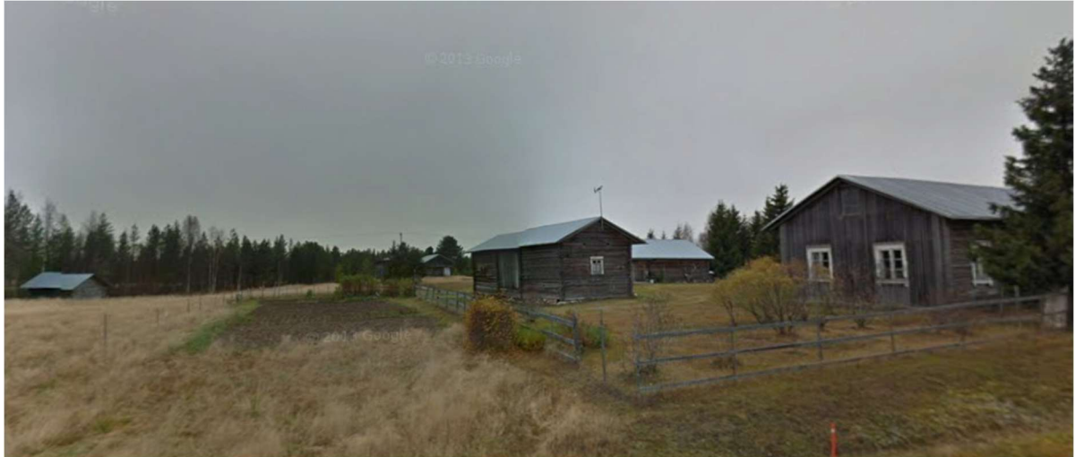
Kuva 21. Juurensuun pihapiirin rakennuskantaa kuvattuna Pekkalantieltä kohti länttä. Oikealla Juurensuun vanha asuinrakennus, keskellä pihapiirin talousrakennuksia ja vasemmalla pellonlaidan talousrakennus. Kuvalähde: Google Street View, elokuu 2011.
