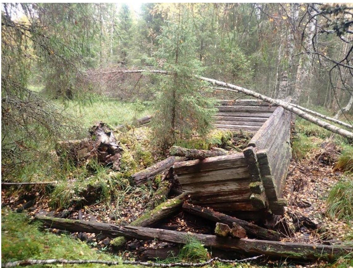
Kuva 79. Sortunut myllyn rakennus. Itään.
