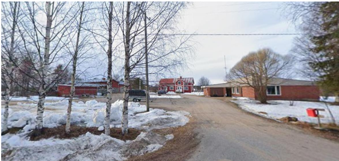
Kuva 20. Ahoniemi kuvattuna Siikamäentieltä. Oikealla todennäköisesti vuonna 1968 valmistunut uudempi lapekattoinen asuinrakennus, keskellä vanhempi asuinrakennus ja vasemmalla 1900-luvun jälkipuoliskon talousrakennuksia. Kuvalähde: Google Street View, huhtikuu 2025.
